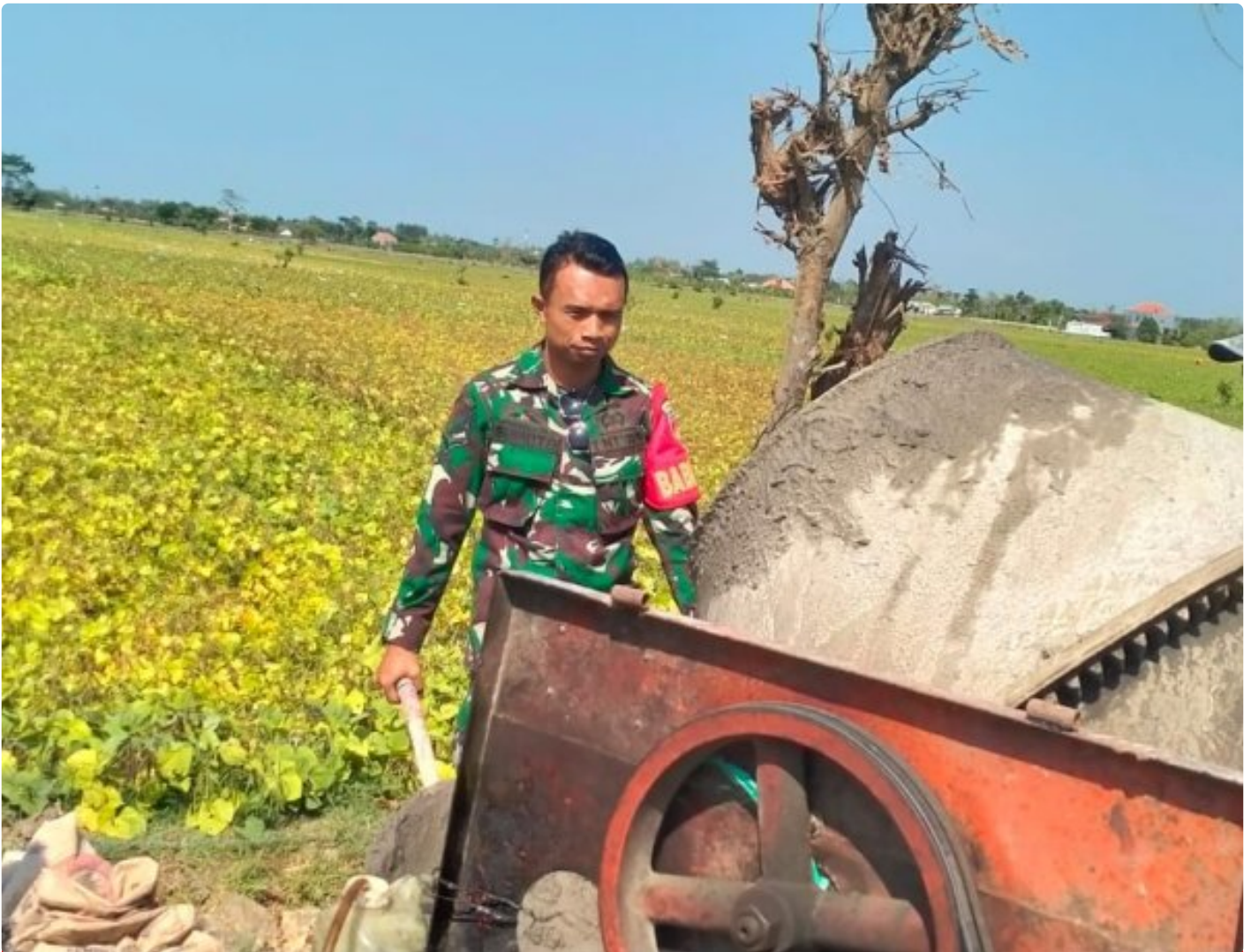
TNI Selalu Hadir Ditengah Rakyat, Babinsa Bantu Warga Buat Talud
